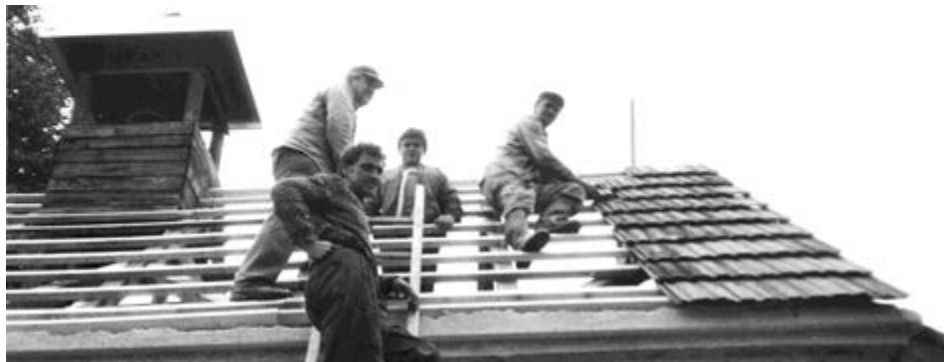
Poslední oprava střechy a zvonice se uskutečnila v roce 1990.
