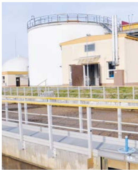
Klíčovou investicí představuje čistírna odpadních vod. Foto: archiv
