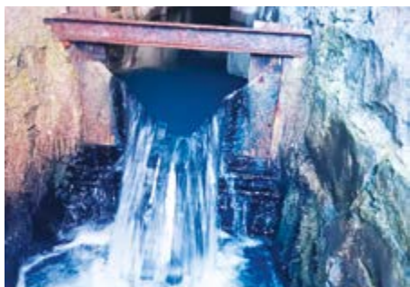
Takzvaný Thomsonův přeliv v jedné části Dědičného štoly, která pod městem odvádí vodu z příbramských důlních děl. Průtok je přibližně 20 l/s a naměřená teplota vody dosahuje 15 °C. Foto: Watrad
