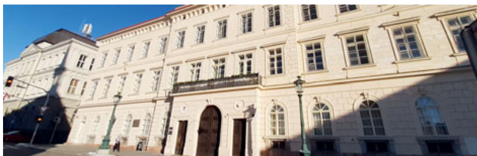
Rekonstrukce by se letos mělo dočkat i bývalé ředitelství Rudných dolů, v první fázi půjde o opravu krovu a střešní krytiny. Foto: Stanislav D. Břeň
