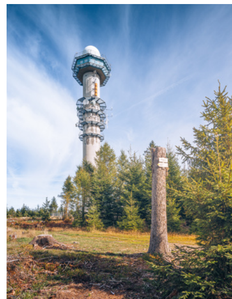
Meteorologická stanice v blízkosti vrcholu Praha.
