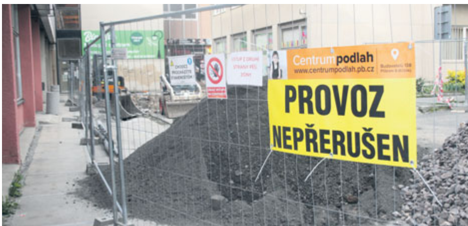
Nepřerušit odpovědné veřejné zadávání. To je cíl platformy, ke které se město nově hlásí.
