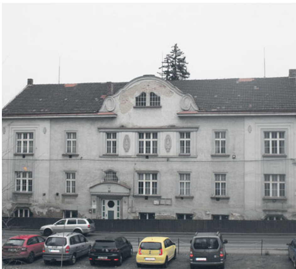
Dům v ulici Čs. armády vyžaduje kompletní rekonstrukci.
