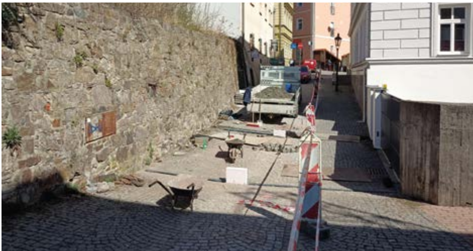
Rekonstrukce povrchu v Potoční ulici.
