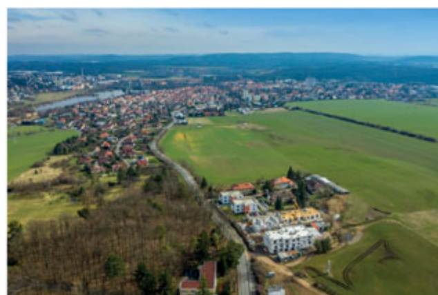
Výstavba ke dni 10. 3. 2024
