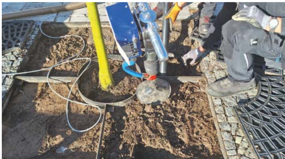
Půdní injektáž pomáhá stromům lépe odolávat nepříznivým vlivům jako zasolenost, sucho a nedostatečný kořenový prostor. Z realizace na náměstí T. G. Masaryka.
