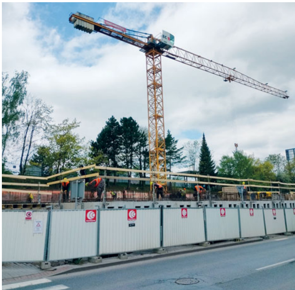
Na autobusovém nádraží pokračuje výstavba nového parkovacího domu pro 176 vozů.
