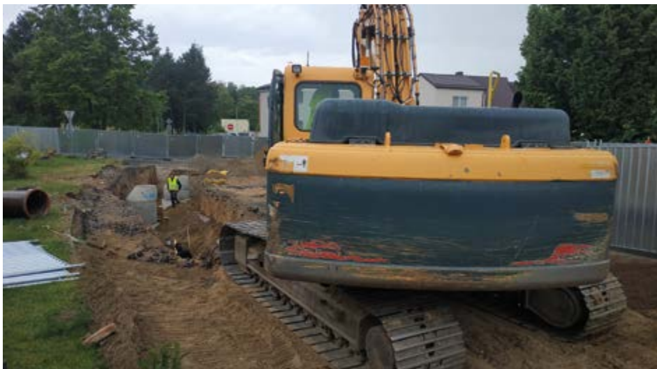
Výkopové práce na křižovatce ulic Bytízská a Na Leštině.
