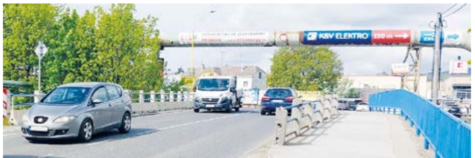
Rekonstrukce mostu byla dlouho odkládána, pak ji ŘSD zahájilo dva dny po prohlídce.
