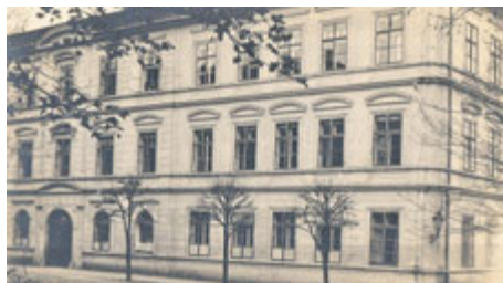
Někdejší učitelství, dnes hlavní budova školy v ulici Na Příkopech 104. Foto z 20. let 20. století.
