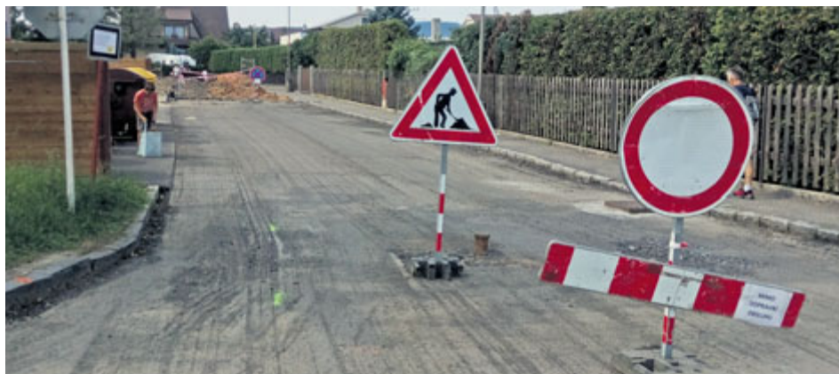
Rozpočtové prostředky půjdou také na opravy silnic a chodníků.
