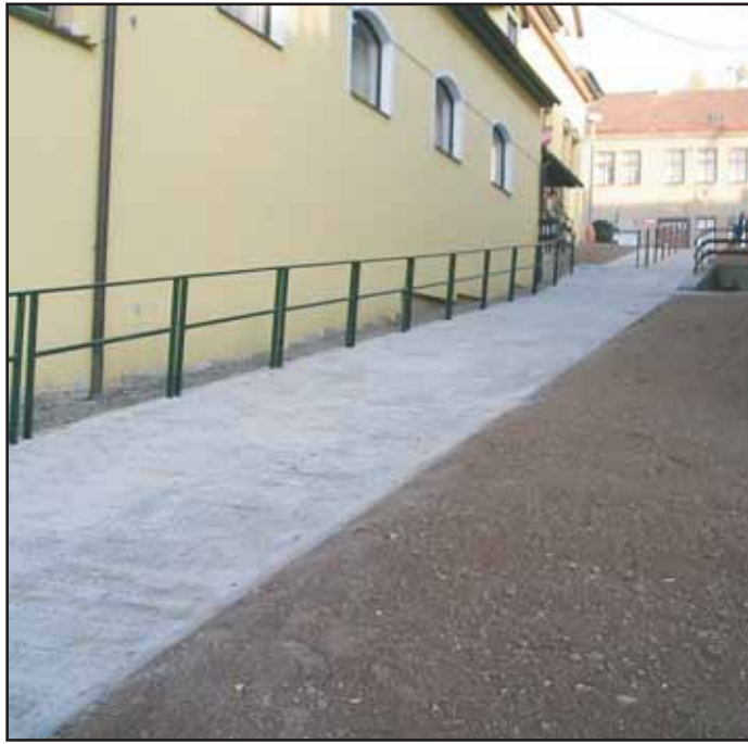
Chodník podél restaurace U Simony byl zrekonstruován v bezbariérové úpravě s novým zábradlím. Náklady dosáhly cca 300 tis. Kč. Akci provedla firma OÚK Dobříš.
