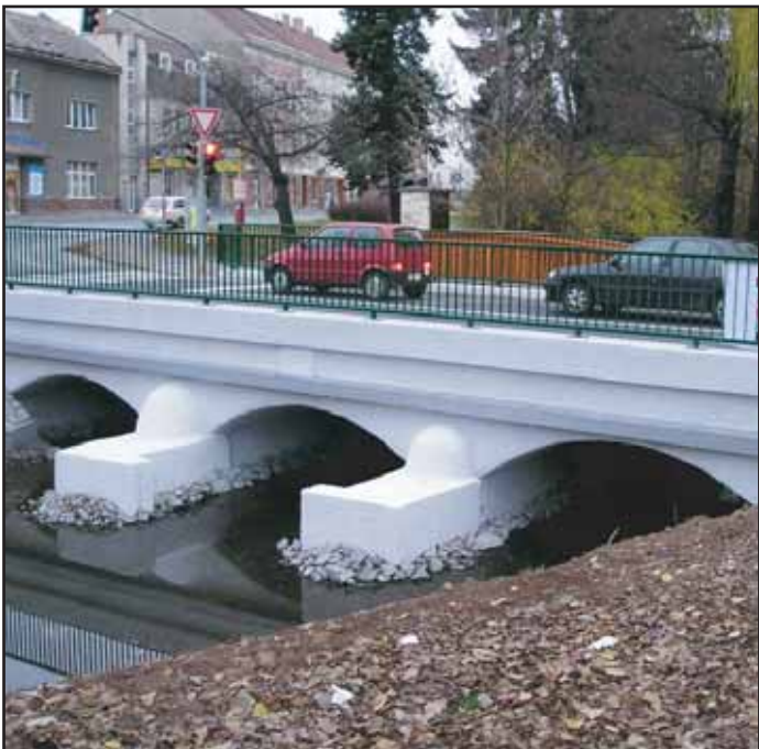
Zrekonstruovaný most přes Příbramský potok v Prokopské ulici byl již dán do provozu. Práce provedla firma STRABAG, celkové náklady činily cca 1,1 mil. korun.
