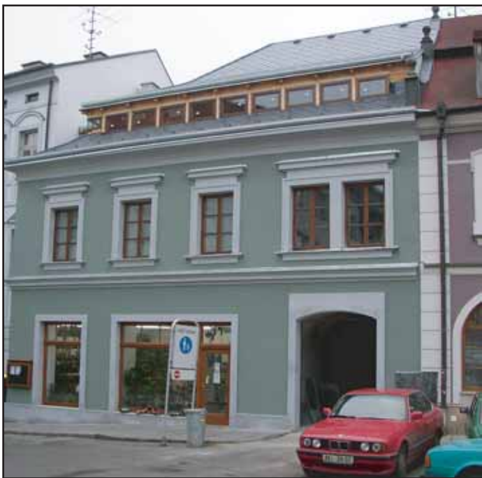
Na začátku Pražské ulice je další krásně opravený dům.
