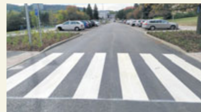
Při výstavbě parkoviště byla opravena i silnice. Foto: Eva Švehlová
