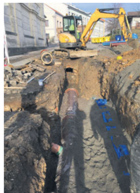
Přibývá havarijních oprav.
