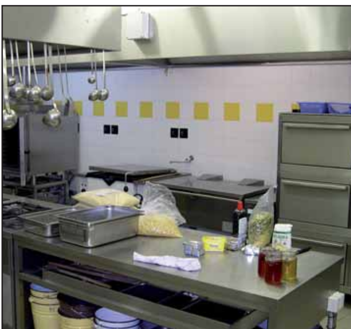
Ve školní kuchyni 3. ZŠ Březové Hory byly provedeny stavební úpravy, bylo dodáno nové gastrozařízení, vzduchotechnika, byl osazen výtah pro dovoz jídla ze suterénních prostor atd. Rekonstrukci prováděla firma Alva spol. s r. o. Cena díla je 4 370 000,- Kč. Po rekonstrukci kuchyně splňuje normy, které předepisuje Evropská unie.
