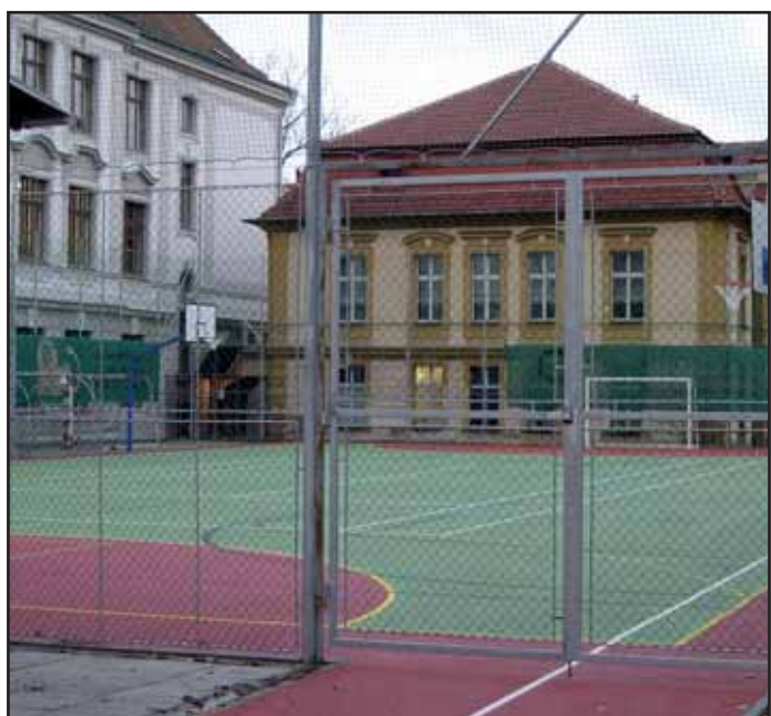
Na sportoviště ZŠ Jiráskovy sady byl položen umělohmotný povrch Conipur EPDM. Zhotovitelem byla firma Tubeko sport, s. r. o., náklady činily 2 016 136,- Kč. Akce zahrnovala položení povrchu na hřiště a běžecké dráhy ve dvou barvách včetně lajnování, dodávku branek, sloupků, sítí, košů a vybudování prostoru pro vrh koulí.
