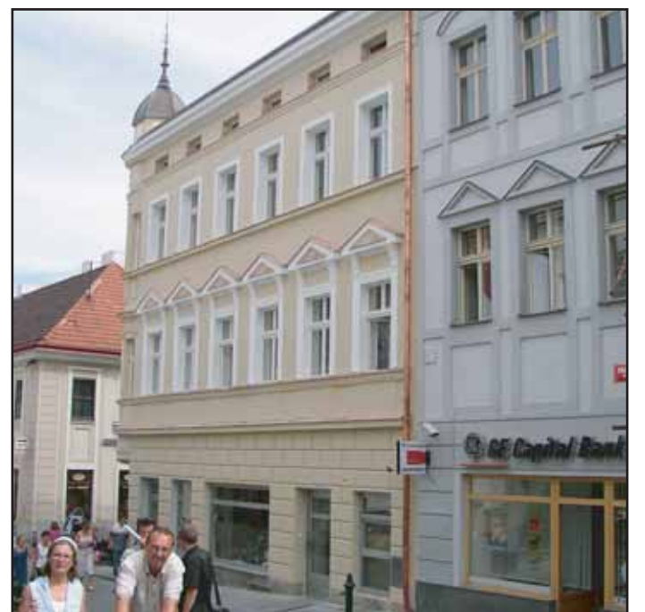
Pan Hanáček, majitel domu v Pražské ulici, nechal opravit fasádu a přispěl ke zkrášlení této rušné oblasti.
