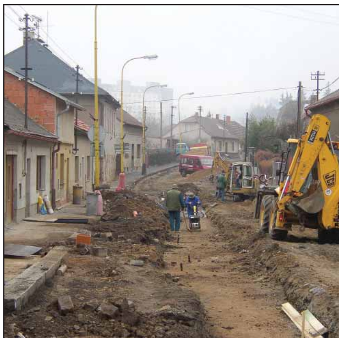
Pohled na probíhající rekonstrukci na Bř. Horách.
