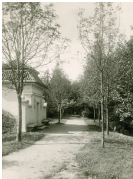
Svatohorský vodojem vybudovaný v roce 1925.
