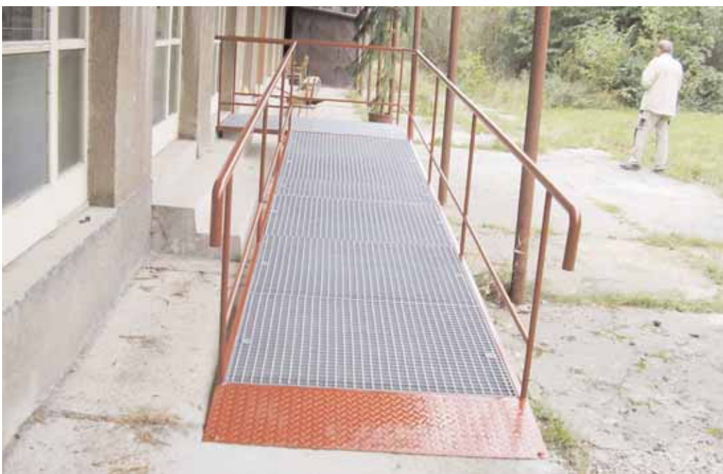
U bývalé 8. ZŠ byla vybudována nová nájezdová rampa pro občany se zdravotním postižením.
