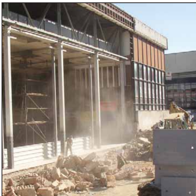
Rekonstrukce sportovní haly byla zahájena.
