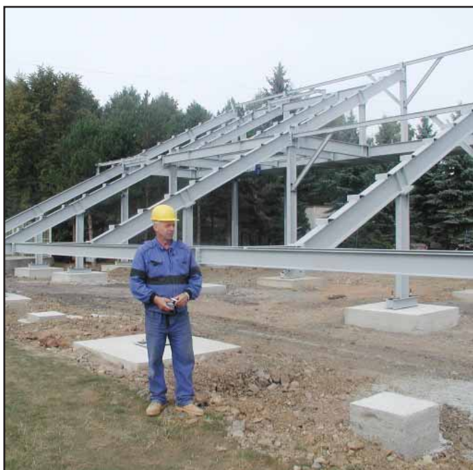
Stavba severní tribuny na Marile.
