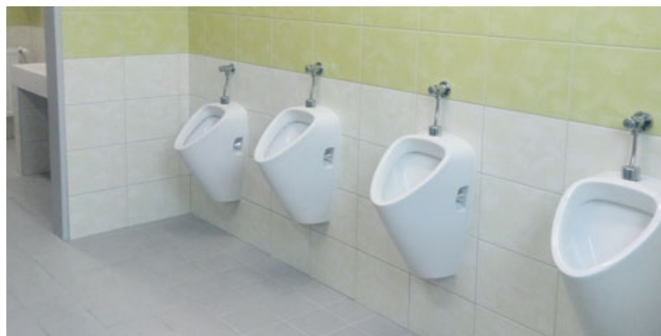
ZŠ Školní má kompletně nová sociální zařízení.
