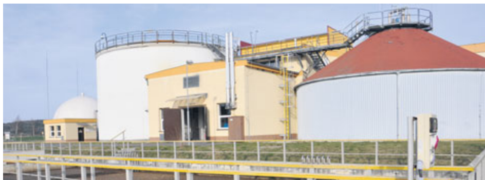
Příbramská čistírna odpadních vod funguje od roku 1962, mezitím prošla několika modernizacemi. Foto: 1. SčV
