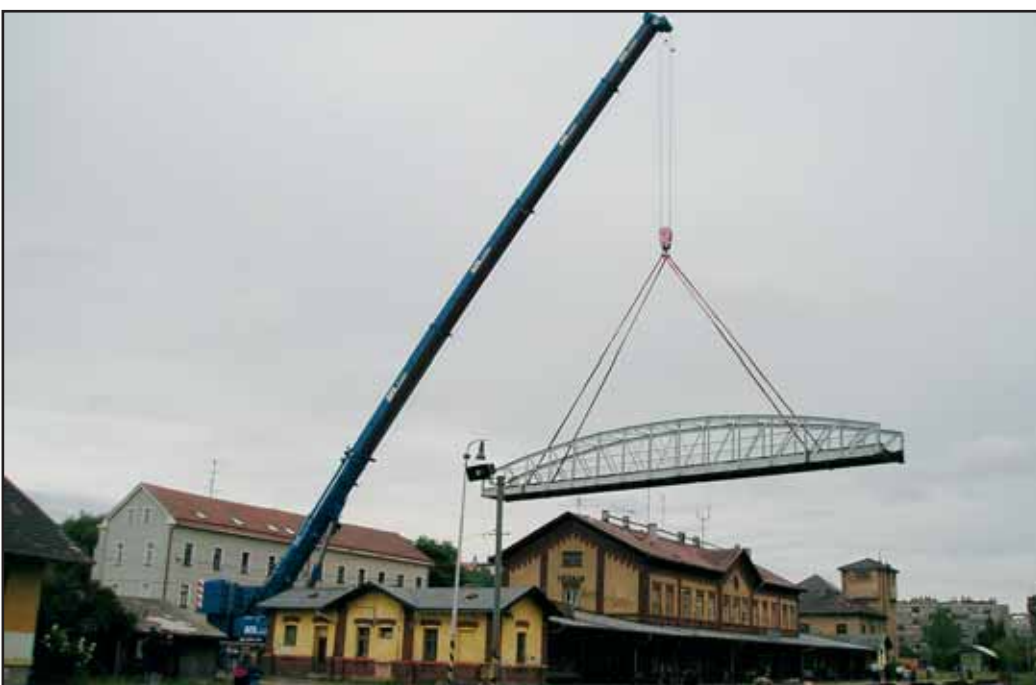
Ocelová lávka u vlakového nádraží byla dne 21. 8. demontována, nyní se provádí celková rekonstrukce a poté bude lávka znovu osazena na místo.
