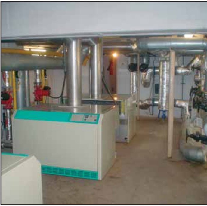
Dne 23. 8. byla dokončena II. etapa celkové opravy kotelny 3. ZŠ nákladem cca 850 tis. Kč bez DPH. Jednalo se o výměnu stávajících zastaralých kotlů, úpravy rozvodů a regulace kotelny.
