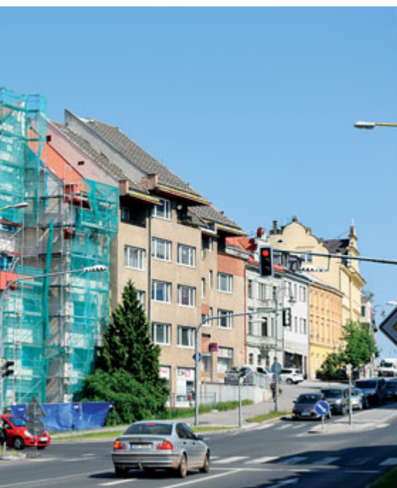
Aktuálně probíhá oprava městského domu na rohu Milínské a Špitálské ulice. Foto: red
