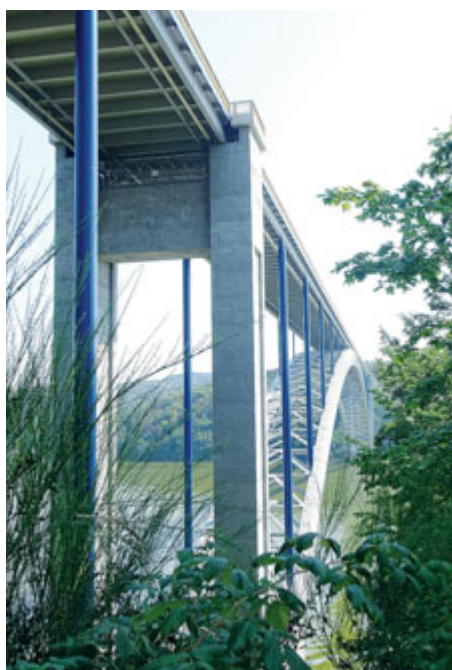
Konstrukce obnoveného Žďákovského mostu
