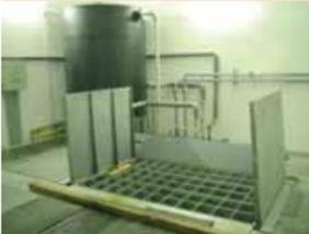
Od zimního stadionu zmizí hromady sněhu. Proč? Protože město investovalo do nové sněžné jámy. Je to betonová jáma o obsahu 15 m<sup>3</sup>, do níž se vysype sníh nastřádaný v rolbě po každé úpravě ledové plochy. Na dně jámy jsou trubky s teplou vodou a ty rozpustí sníh. Voda z rozpuštěného sněhu se znovu používá na úpravu ledu. Tím ušetří zimní stadion za sezonu na jedné ledové ploše až 2 000 m<sup>3</sup> vody z vodovodního řadu.
