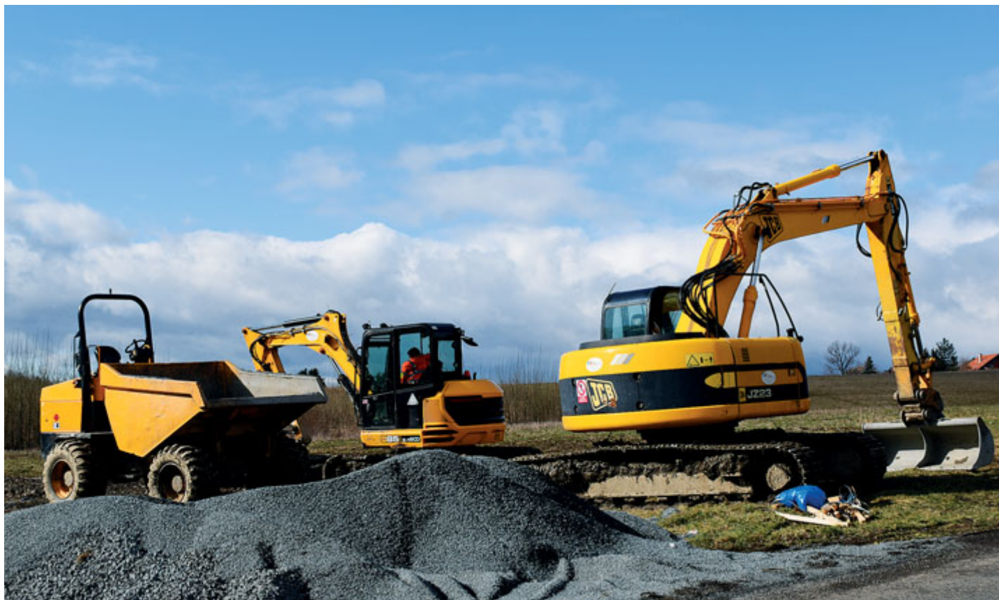
V Lazci již začaly práce na nové kanalizaci.
