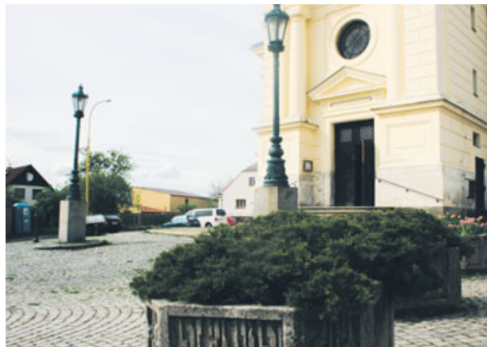
Náměstí J. A. Alise čeká na rekonstrukci.
