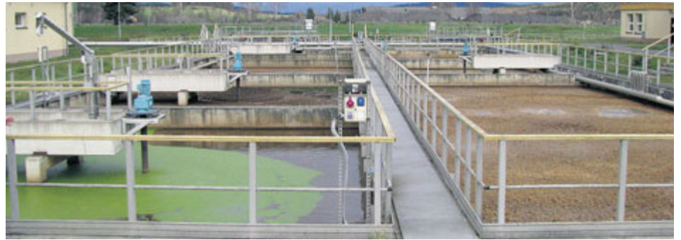
Čistírna odpadních vod v Příbrami.
