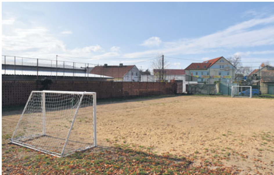
Nejvýznamnějším letním úspěchem Osadního výboru na Březových Horách je obnova hřiště Na Cvičně...
