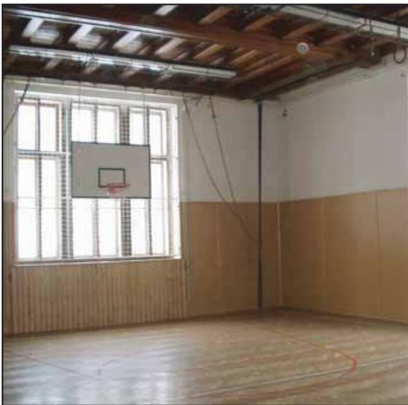
V tělocvičně bylo vyměněno obložení, byly instalovány konstrukce na koše, nové rámy se sítěmi chránícími okna, nové kryty radiátorů, větrací mřížky.
