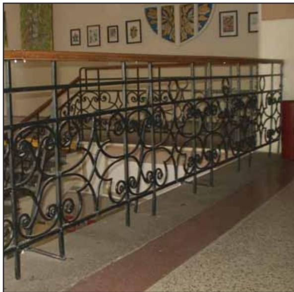
Kvůli bezpečnosti dětí bylo v této škole zvýšeno zábradí. Zábradlí je původní, ale není poznat rozdíl mezi starým a nastaveným. Akci provedla firma „Zámečnictví Kuba“.
