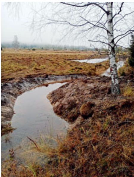
Budování tůň a revitalizace koryta vodního toku
