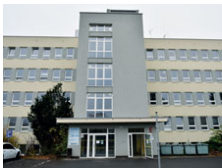
Část budovy je už po rekonstrukci. Foto (2x): ONP
