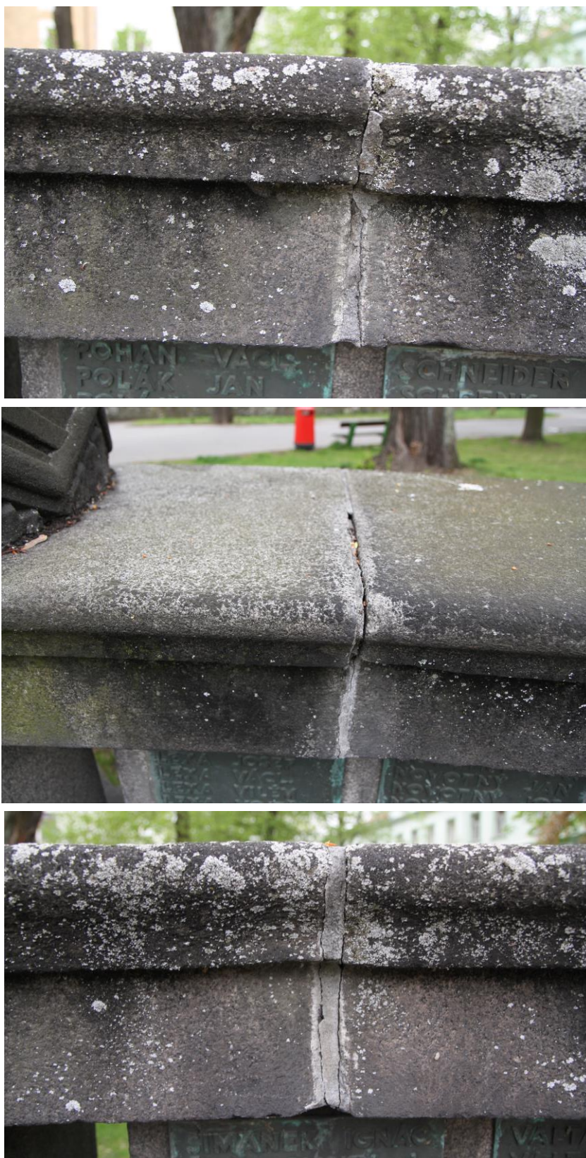
Detaily spárování záklopu
