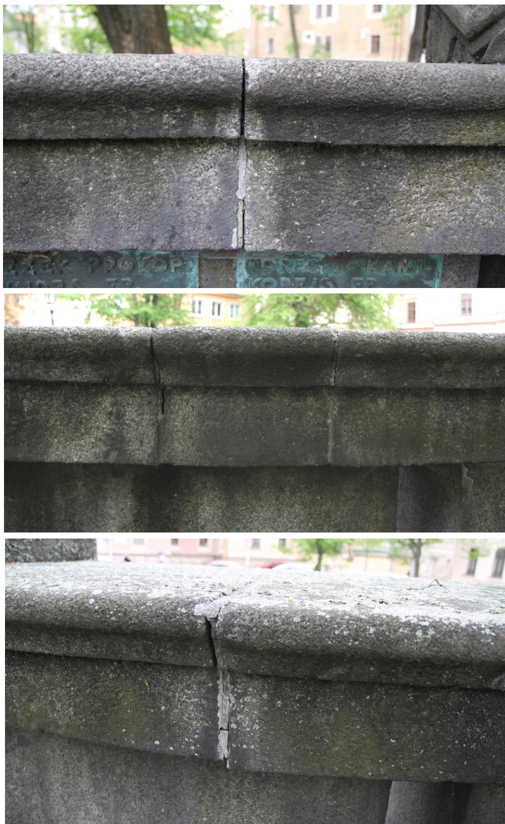
Detaily spárování záklopu
