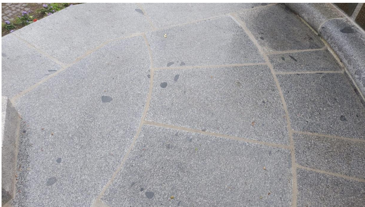
Konečný stav po restaurování a přespárování žulové architektury
