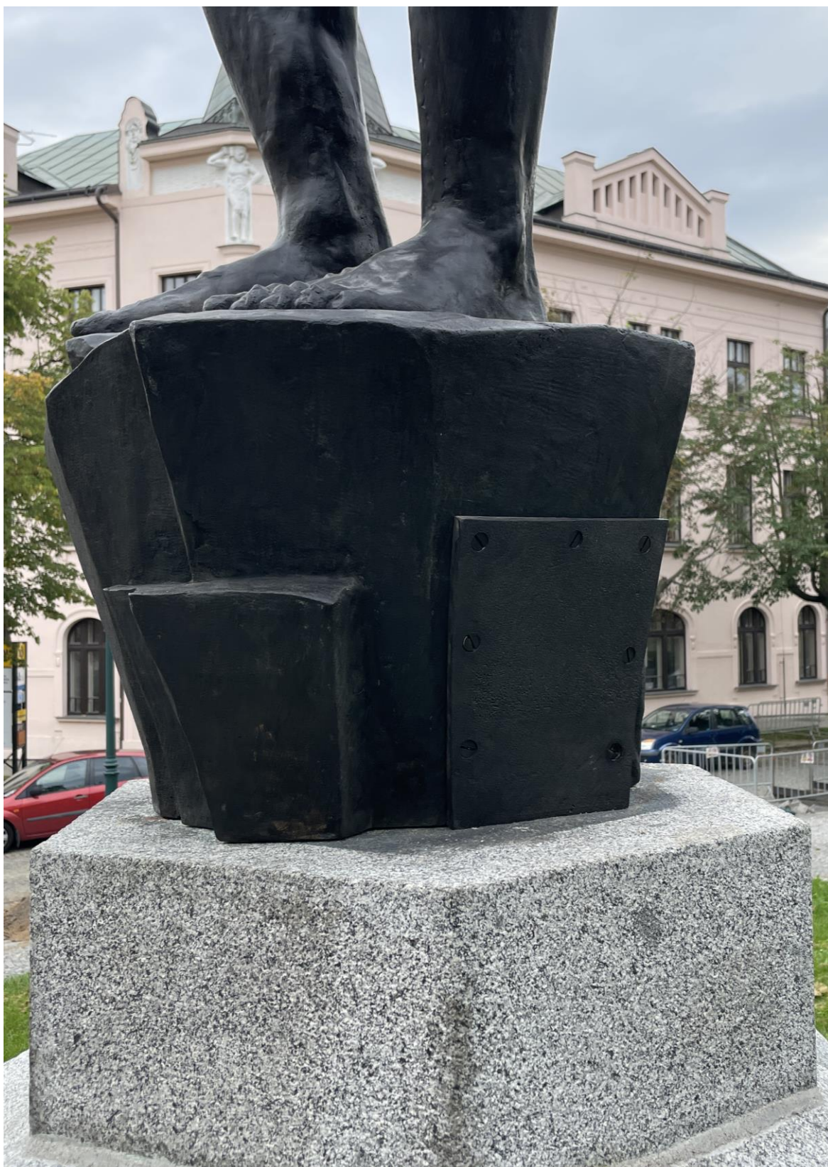
Pohled po uzavření revizního otvoru
