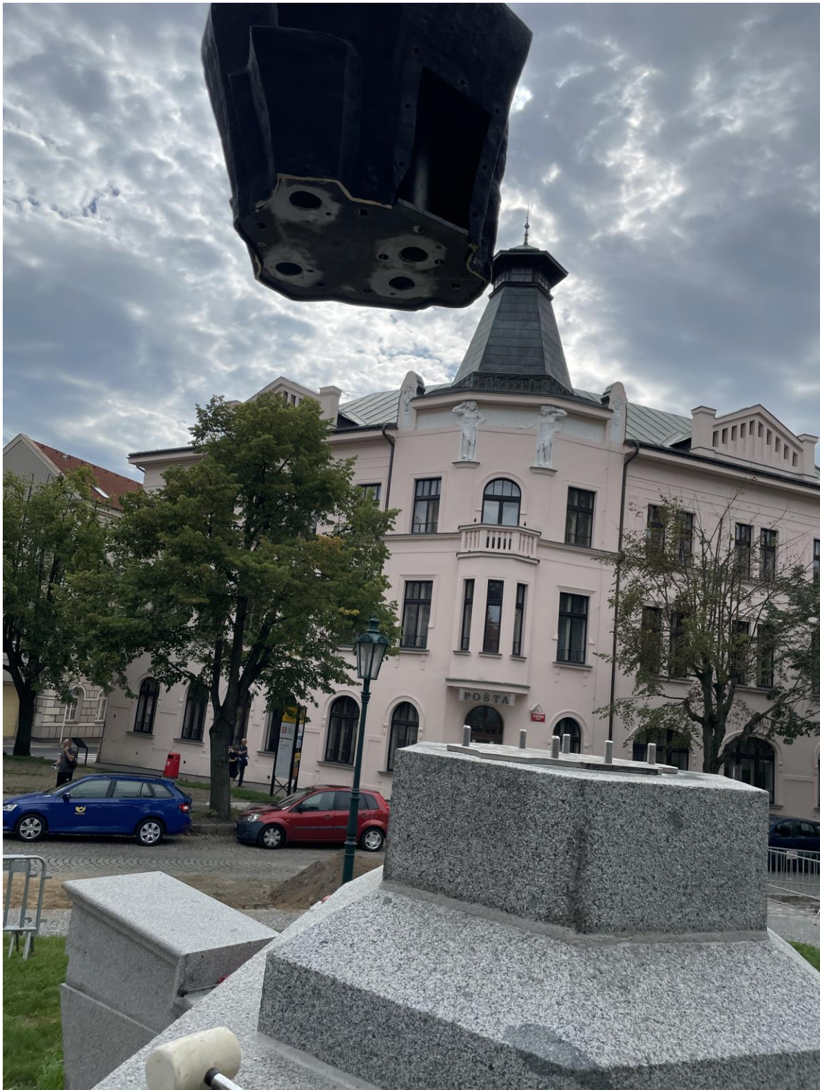
Průběh osazování sochy s platí (spodní část sochy se čtyřmi otvory) na podložku již osazenou do kamene
