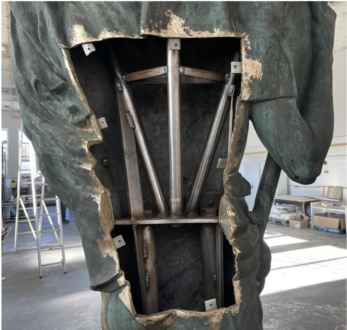
Provádění nové nerezové konstrukce do sochy
