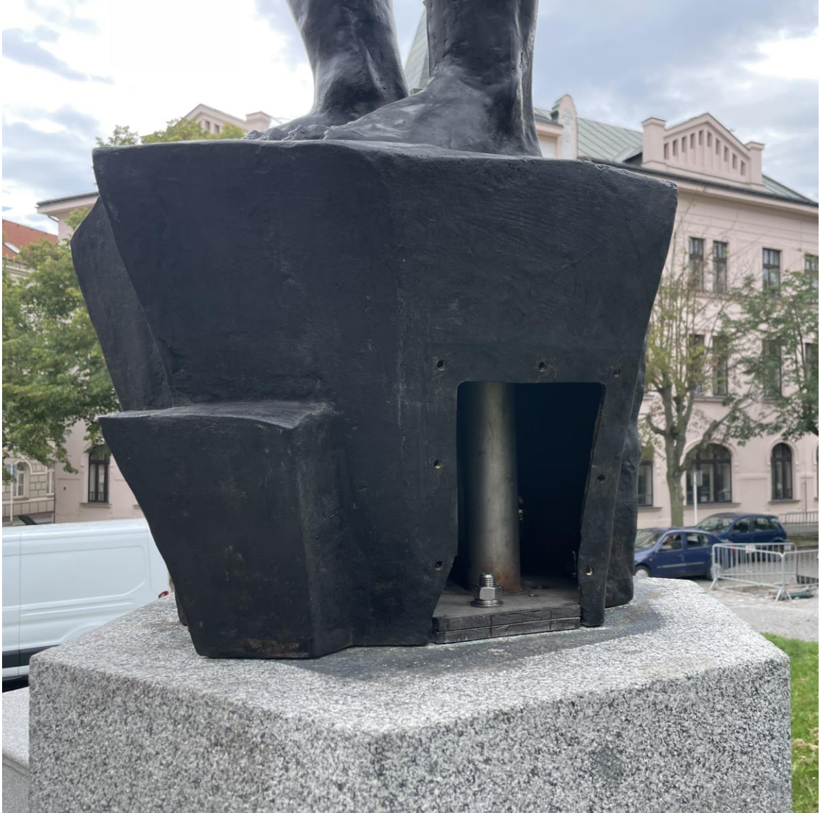
Stav po osazení s otevřeným revizním otvorem
