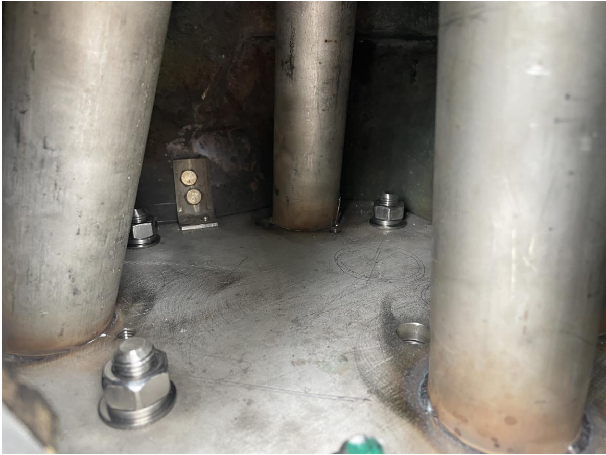
Detailní pohled do revizního otvoru s detaily šroubových ukotvení
