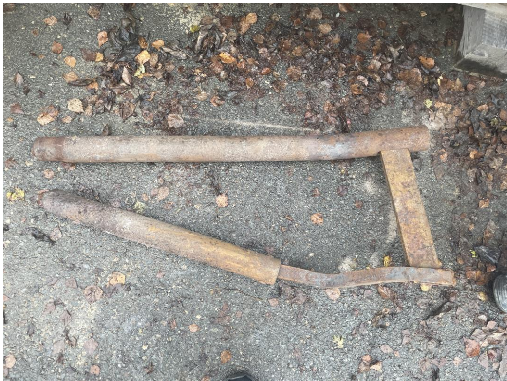
Horní fotografie dokumentuje montérku v pase a spodní vyndanou nevhovující konstrukci
