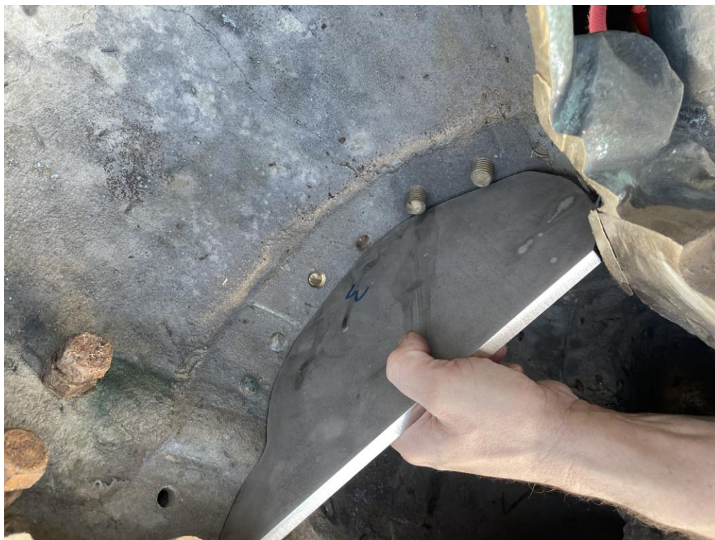
Provádění vkládání nových výpalků pro stabilizaci-statiku celé sochy
