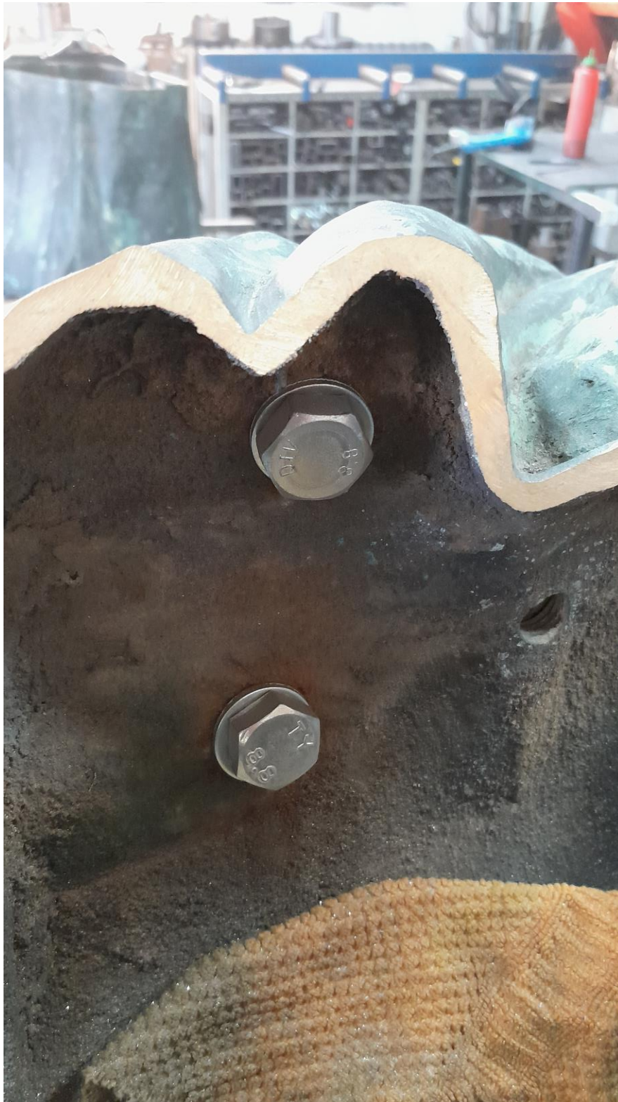
Nové nerezové stahovací šrouby
