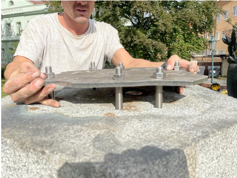
Osazování protikusu pod sochu do kamene
