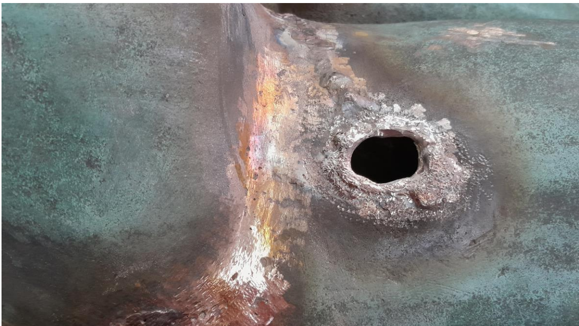
Mechanické stahování prasklin
