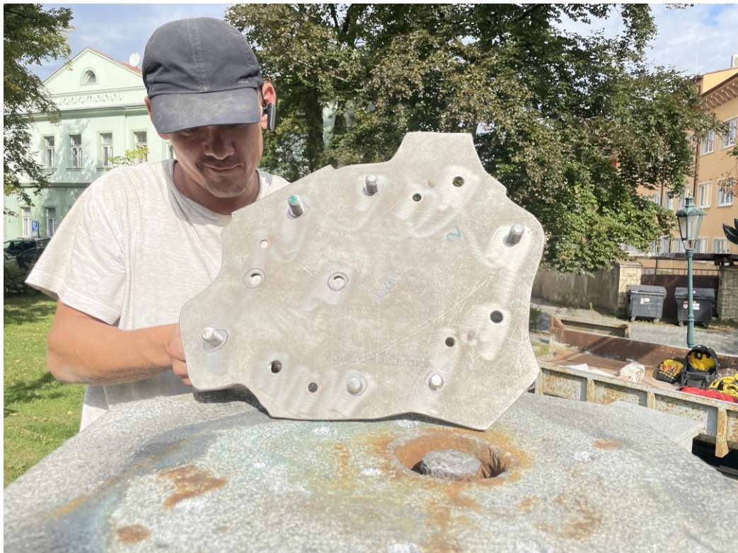
Příprava protikusu z nerezové oceli, jenž bude osazen na chem. Kotvu do kamene
