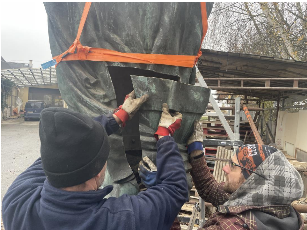
Provádění nového montážního otvoru v zádech
