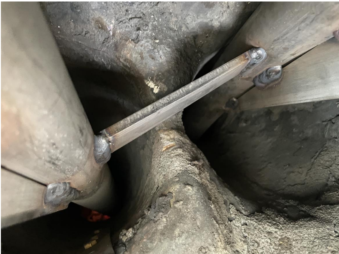
Provádění nové nerezové konstrukce do sochy
