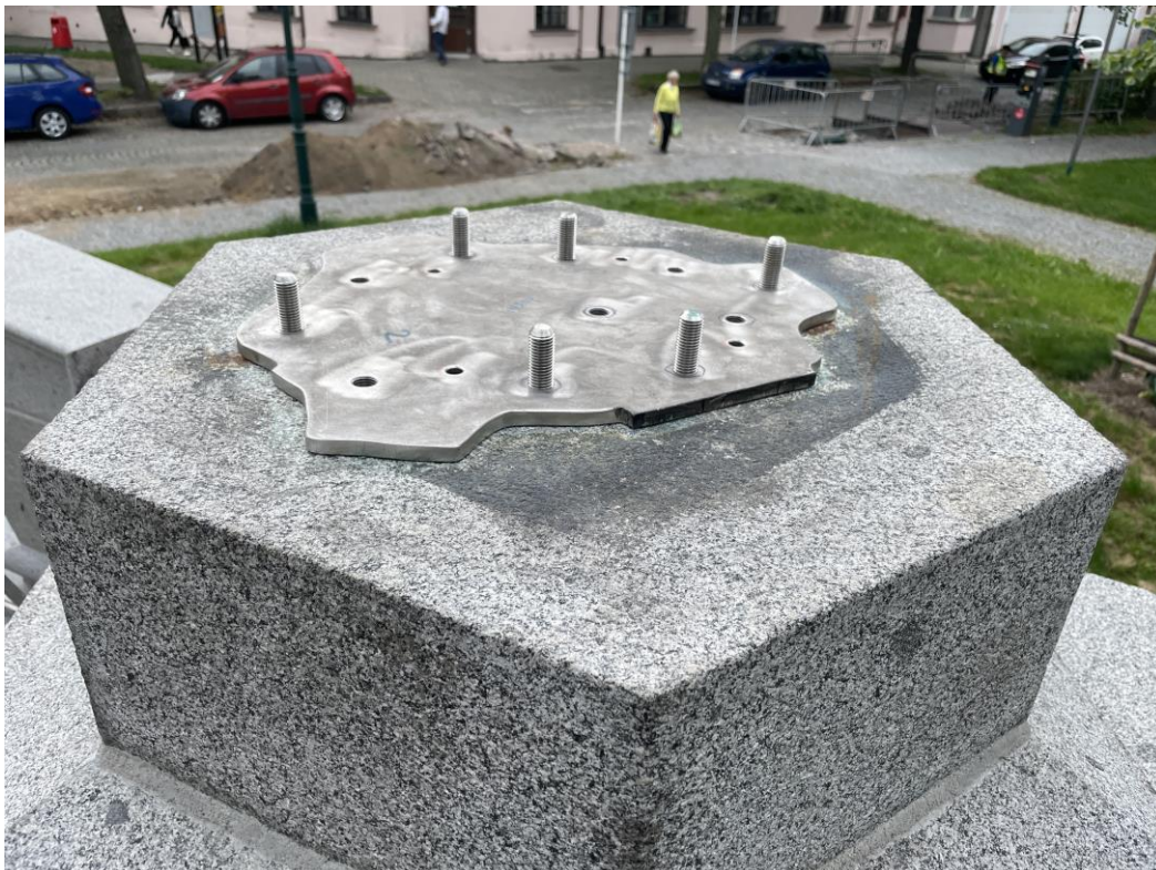
Protikus po osazení a s připravenými závitnicemi pro osazení vlastní sochy
