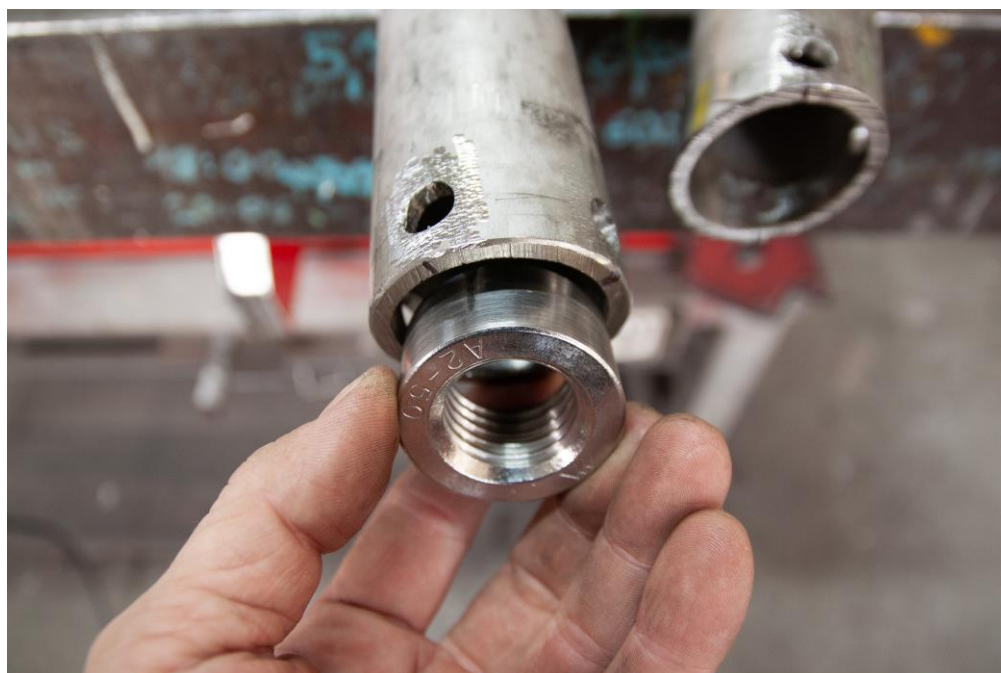
Provádění nové nerezové konstrukce do sochy
