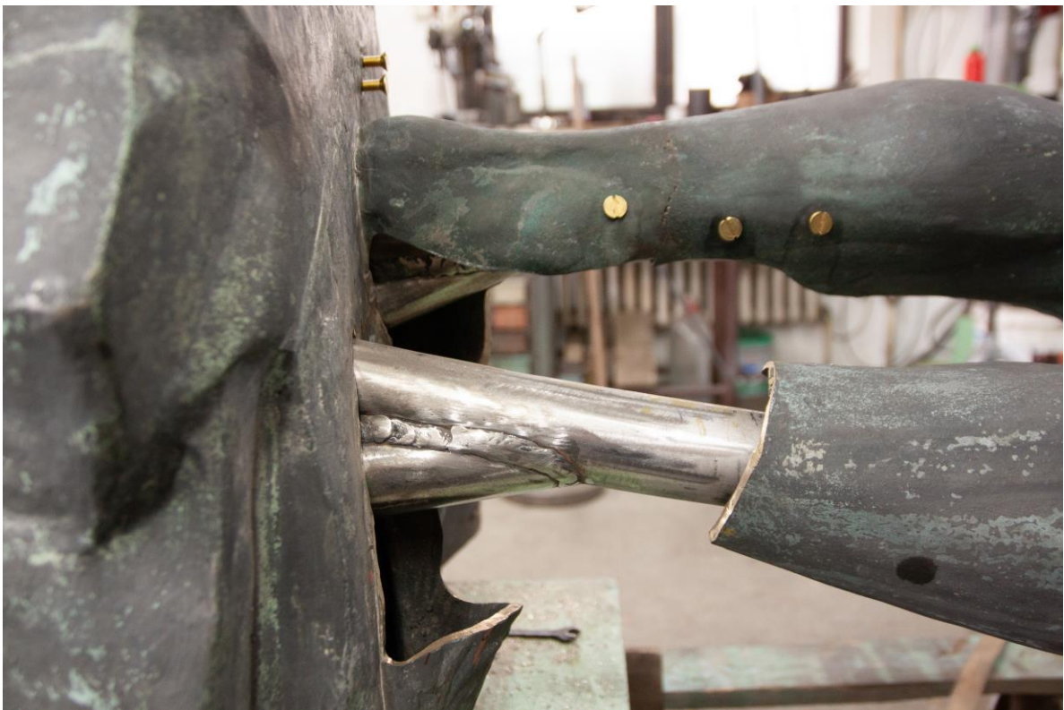
Provádění nové nerezové konstrukce do sochy
